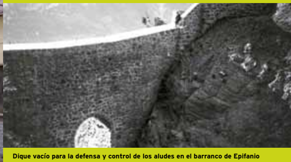
Dique vacío para la defensa y control de los aludes en el barranco de Epifanio
