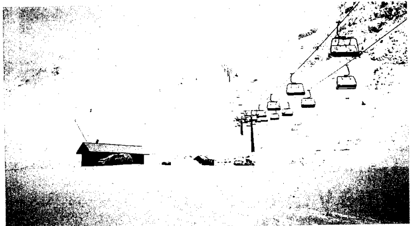
Imagen del estado que presenta la estación de Formigal. s.e.
